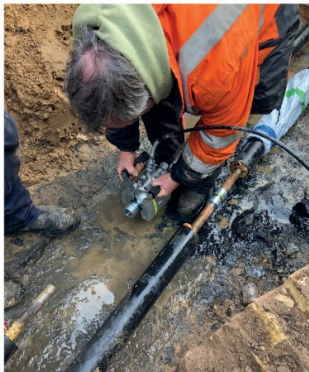
Bild 2. Mit handlichen Presswerkzeugen und einer akkubetriebenen Hydraulikpumpe wird die Rohrverbinding hergestellt
