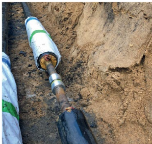
Bild 1. Mit dem Pipe-System lassen sich Rohre innerhalb weniger Minuten miteinander verbinden
